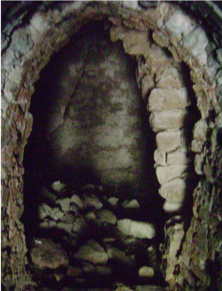
Para apagar el horno se procede primero a barrer la parrilla y a jalar el cárcamo, a continuación se tumba la compuerta y se “tapa” la parrilla poniendo sobre estas grandes laminas (hechas a partir de canecas metálicas), finalmente se retiran varios ladrillos de algunas ojadas del capelo para ampliarlas y permitir que penetre de manera más abundante el aire y acelere el enfriado de la piedra.
